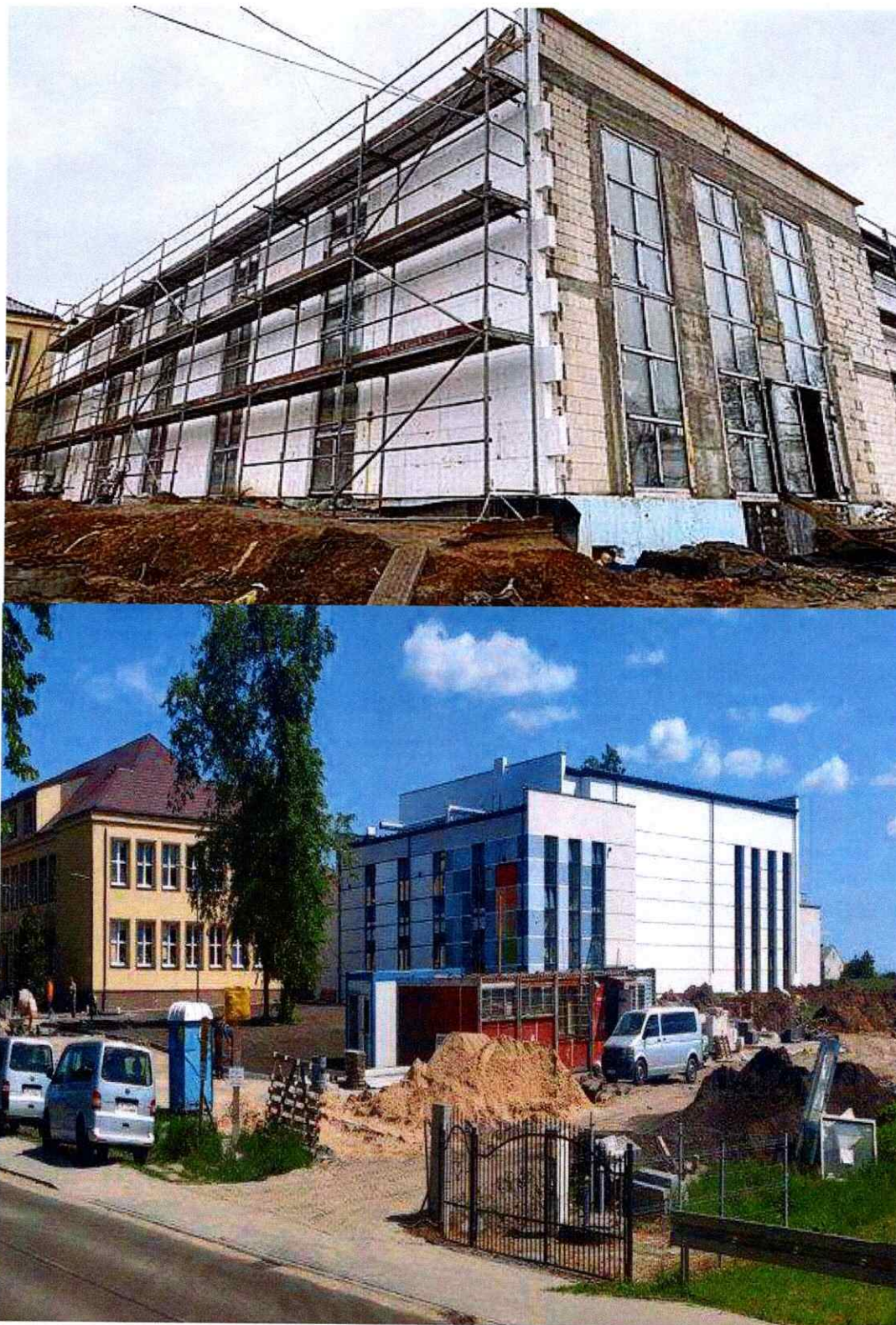
Rysunek 18. Budowa sali sportowo-widowiskowej przy Zespole Szkół w Zbrachlinie.
